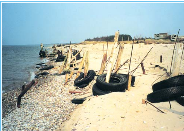
22. att. 1999. gadā sagraudā krasta aizsargbūve Liepājā pie attīrīšanas iekārtām.
