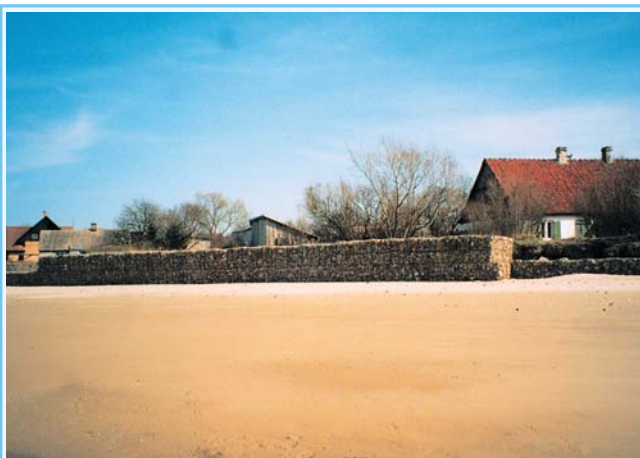
25. att. Zemā smilšainā krasta aizsardzība pret noskalošanos vētrās ar gabioniem Pāvilostā.
