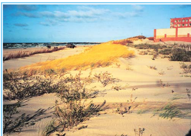
27. att. Kāpu graudzāļu stādījumi noraktās priekškāpas atjaunošanai Ventspilī.
