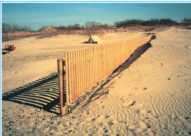
28. att. Koka listišu sētiņu uzstādīšana Ventspils pludmalē pārpūšamo smilšu uzkrāšanai 2003. gadā.
