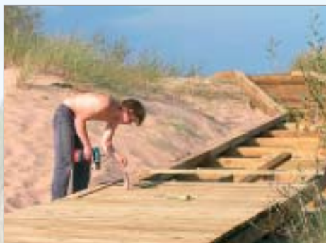
2 m platās koka seguma laipas Daugavgrīvā būvē SIA "Fiberglass" darbinieki (2005. g.)
