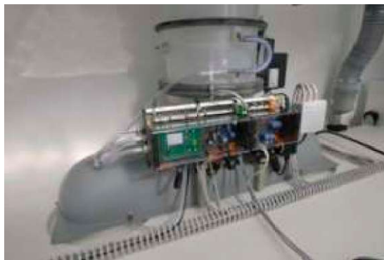
Velkmes skapja ātrdarbības VAV vārsts ar motoru.
