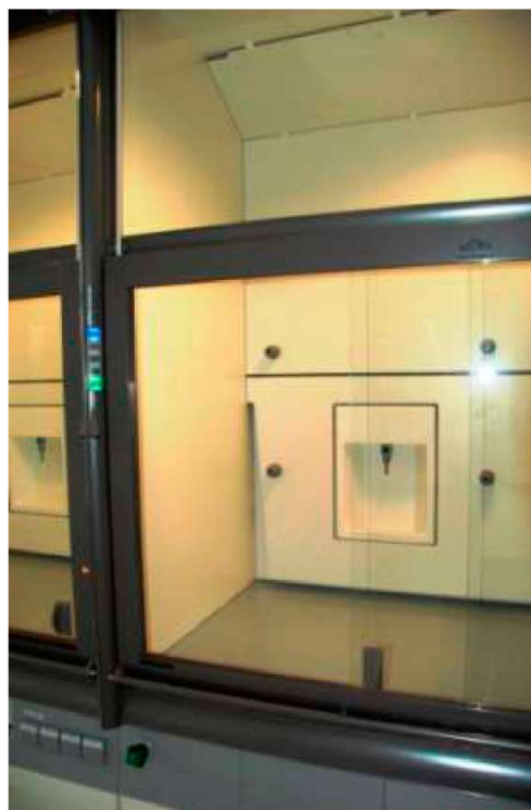
Velkmes skapja aizmugurējā sienā iebūvēta izlietne ar aukstā ūdens krānu.
